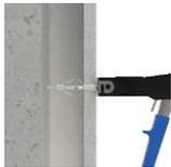
Mettre la tête de la vis dans la tenaille d'installation et actionnez-la jusqu'à ce que se produise l'expansion totale de la cheville en faisant attention de ne pas l'extraire.
