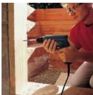
Fixation des cadres et des sous-trames de portes, fenêtres, etc.
